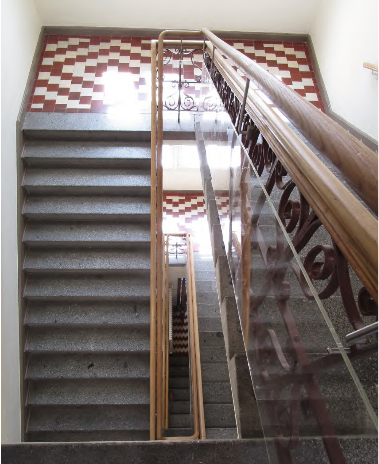
Abb. 3 Eines der Nebentreppenhäuser. Die Geländer wurden auch hier entsprechend den Vorgaben der Unfallkasse ertüchtigt – HL/Abt. Denkmalpflege/Köhn.
