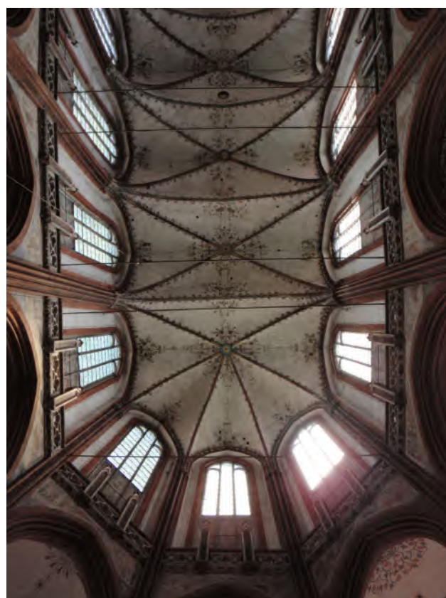
Abb. 2 Hansestadt Lübeck, St. Marien, Deckenansicht des Hochchors, o.J. – HL/Abt. Denkmalpflege/Bildarchiv.
