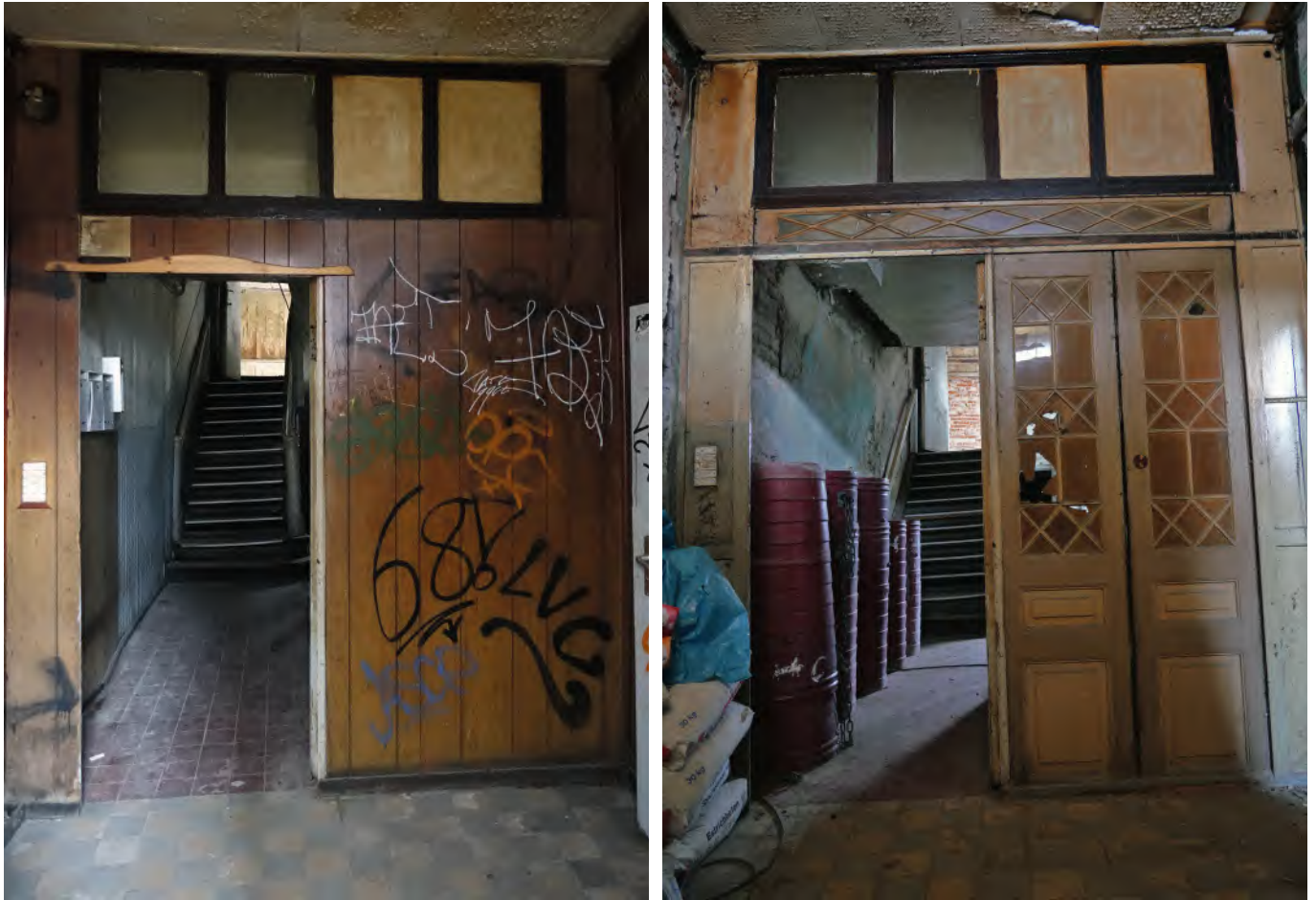
Abb. 2 Hansestadt Lübeck, Böttcherstraße 18, Flurabtrennung vor der Sanierung mit jüngerer Einbauten (links) und nach Freilegung des originalen Windfangs, 2023 – HL/Abt. Denkmalpflege/Krischke.
