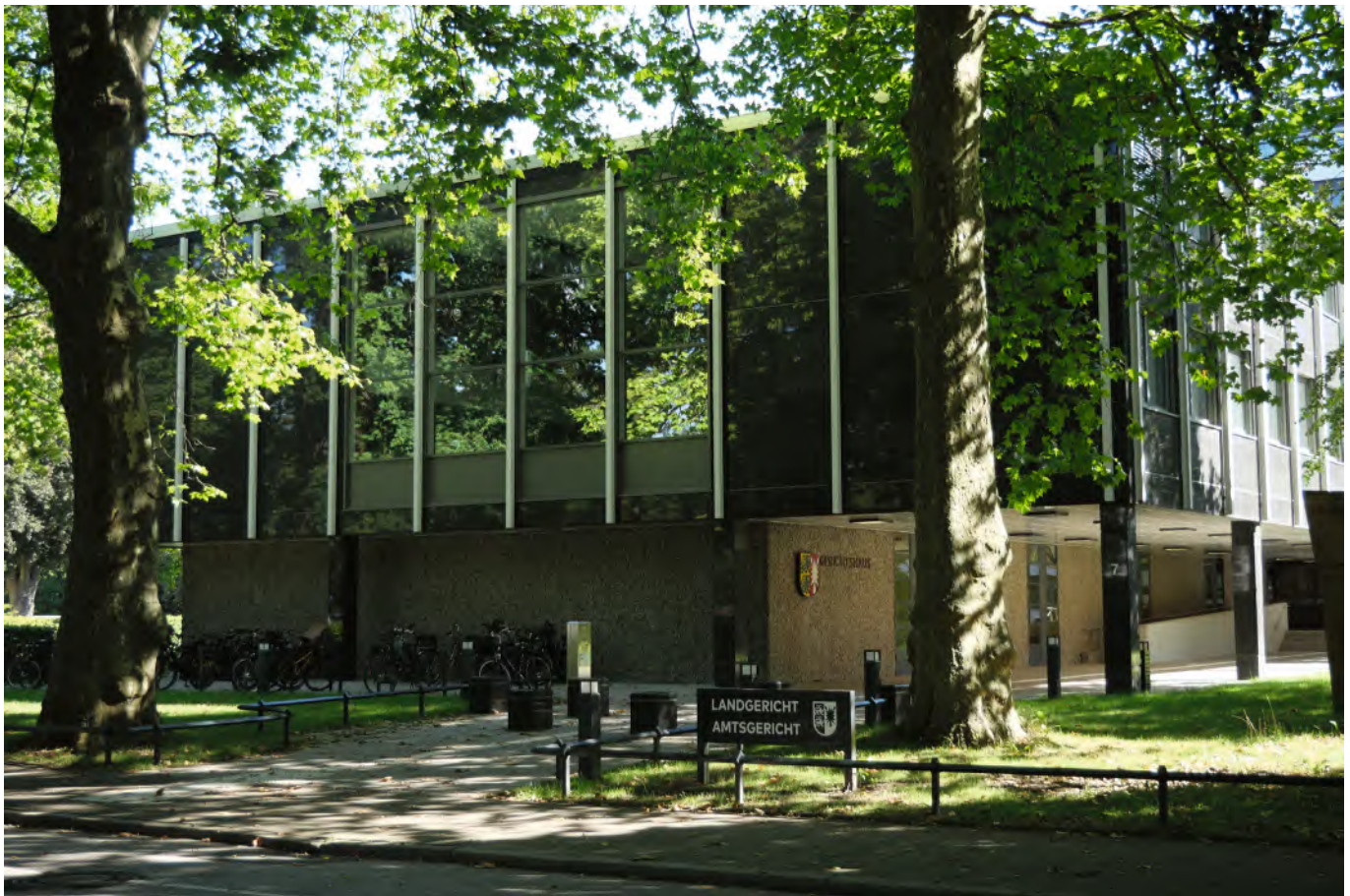
Abb 2 Außenansicht des markanten Schwurgerichtssaals – HL/Abt. Denkmalpflege/Köhn.
