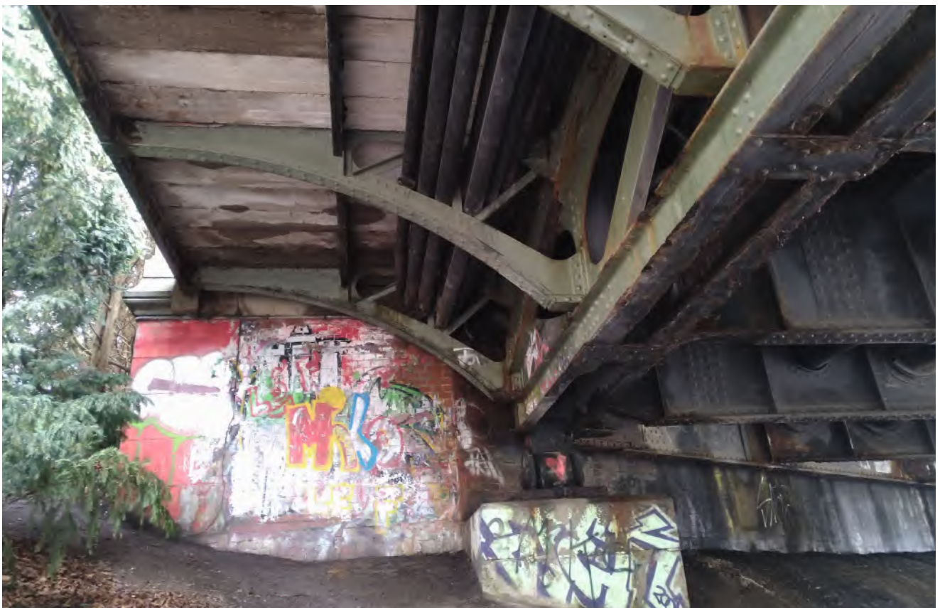
Abb. 6-7 Ansicht der Brückenunterseite. Auf den Konsolen lagern die Fußgängerwege – HL/Abt. Denkmalpflege/U. Köhn.
