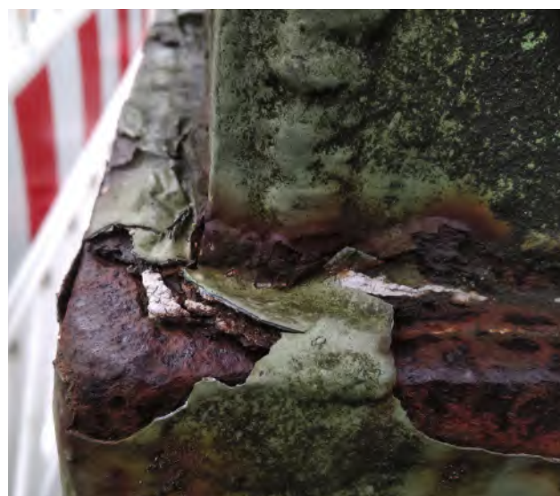
Abb. 2 Detail einer Pylonbasis – HL/Abt. Denkmalpflege/Köhn.
