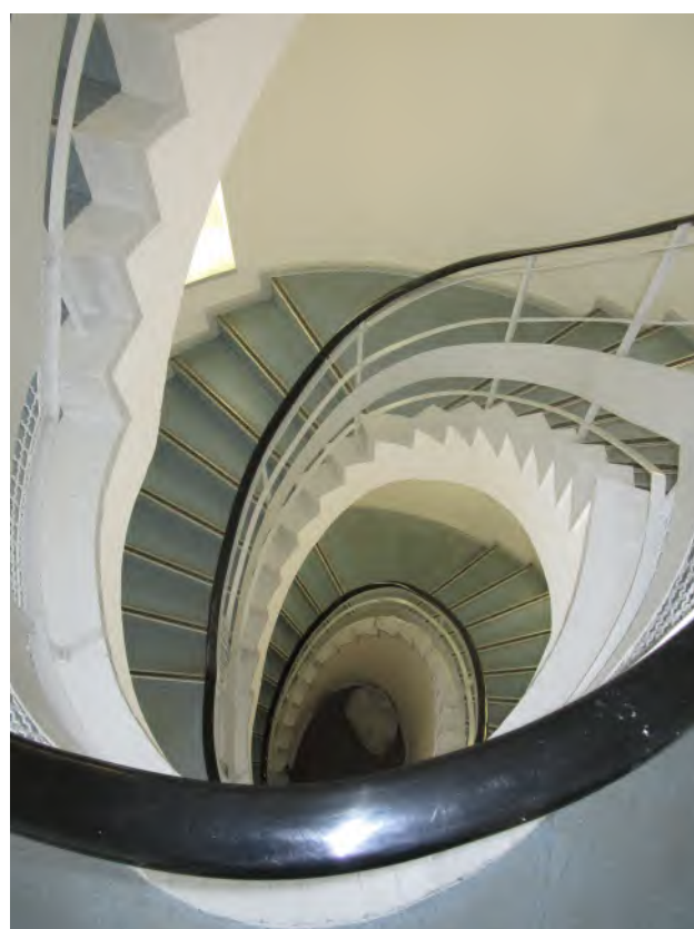
Abb 2 Hansestadt Lübeck, Fischstr. 2-6, Innenansicht des Hausflurs mit geschwungener Treppe, 2022 – HL/Abt. Denkmalpflege/Seemann.
