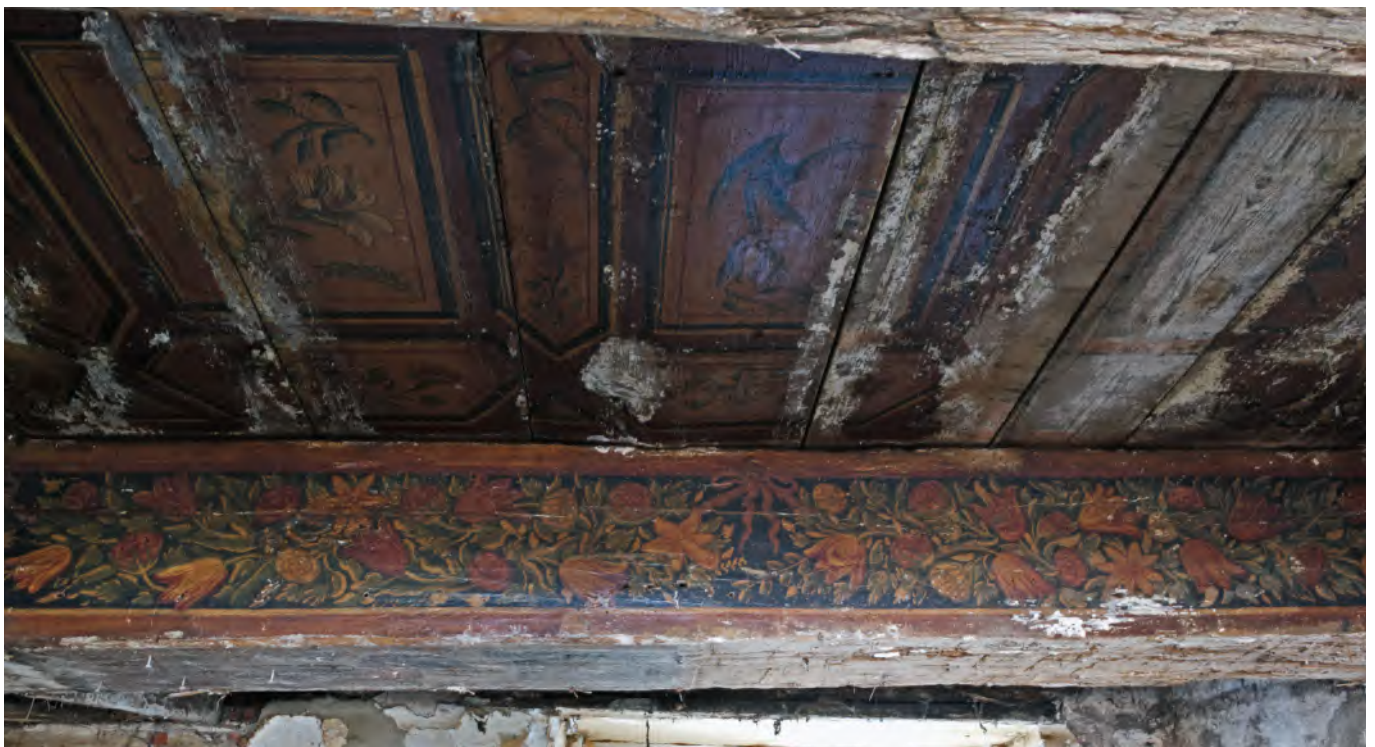
Abb 3 Hansestadt Lübeck, Böttcherstraße 18, Holzbalkendecke mit Malerei aus dem 17. Jahrhundert. Der Balken ist auf der Unterseite bearbeitet was auf eine konsolenartige Profilierung hindeutet die ebenfalls mit dem 17. Jahrhundert in den Dielendecken auftreten, 2023 – HL/Abt. Denkmalpflege/Krischke.
