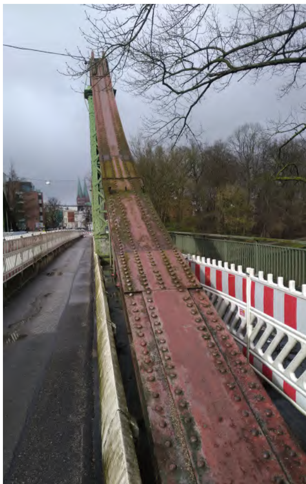
Abb. 5 Blick auf einen genieteten Brückenobergurt – HL/Abt. Denkmalpflege/U. Köhn.
