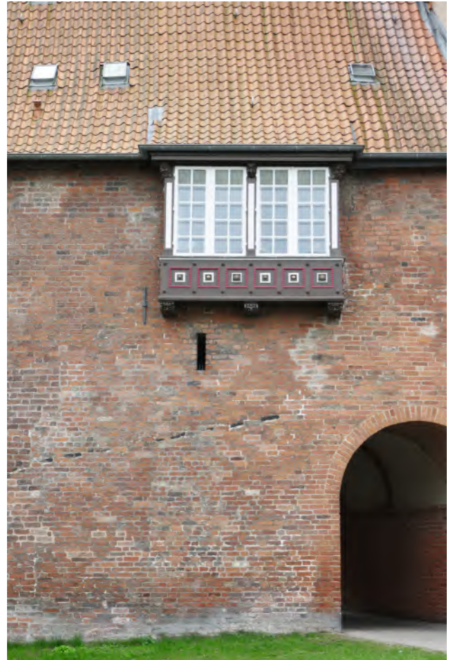
Abb. 7 Der sanierte Erker neben dem Burgtor nach der Instandsetzung – HL/Abt. Denkmalpflege/Knipscheer..
