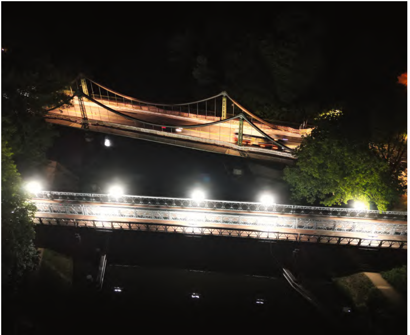
Abb. 8 Nächtliche Drohnen-Aufnahme von Mühlenbrücke und Interim für Fuß- und Radverkehr – HL/Abt. Brückenbau/A. Köhn.
