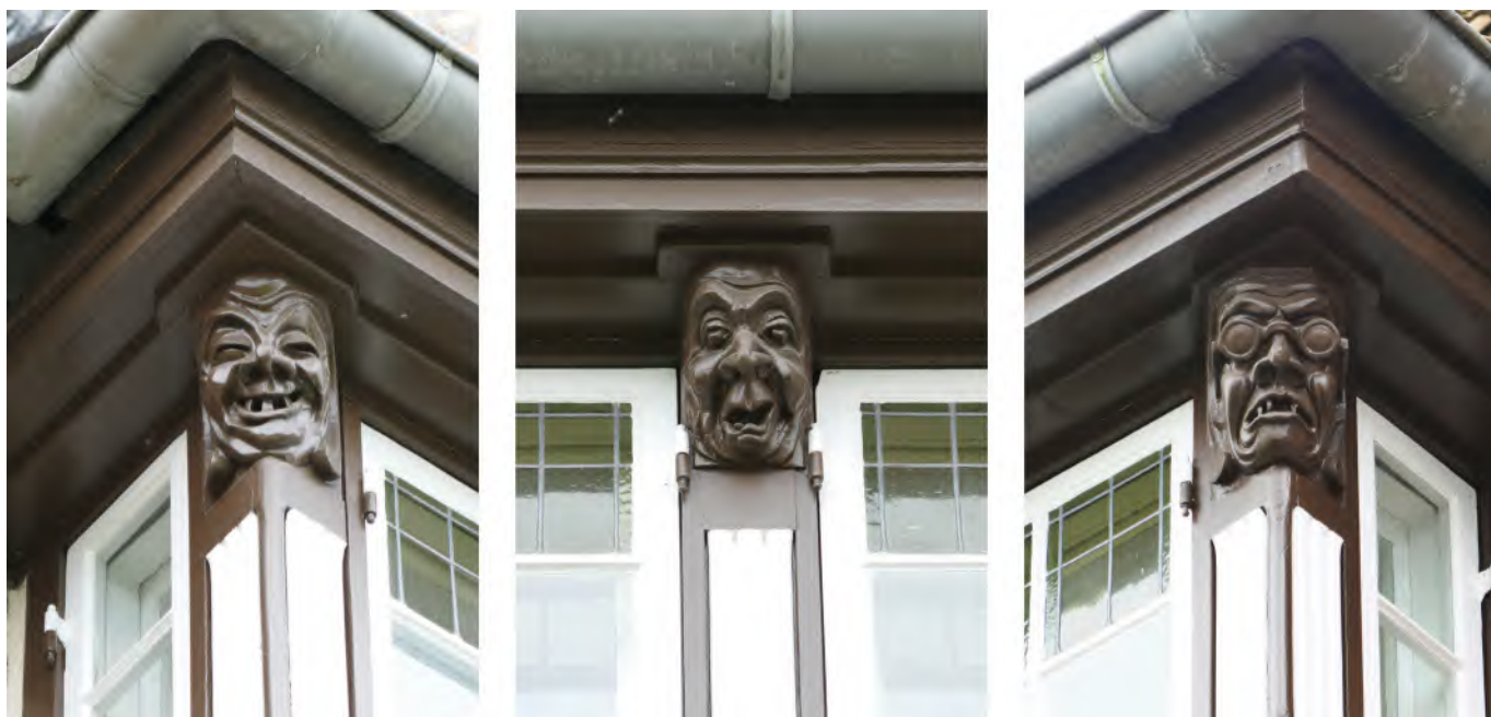
Abb. 8 Fallen erst bei näherem Hinsehen auf: Die als Pilasterköpfe fungierenden beschnitzten Sparrenköpfe am Erker neben dem Burgtorturm – HL/Abt. Denkmalpflege/Knipscheer.
