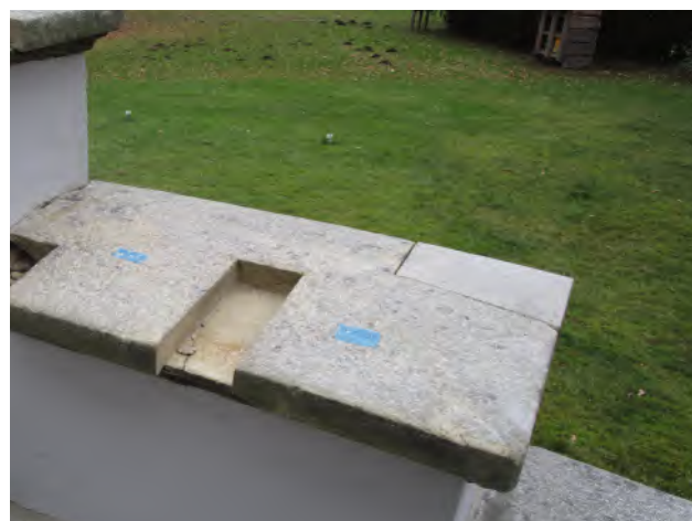
Abb 2 Schadhafte Bereiche wurden ausgearbeitet, um Ergänzungen als sog. Vierungen einzukleben – HL/Abt. Denkmalpflege/Köhn.
