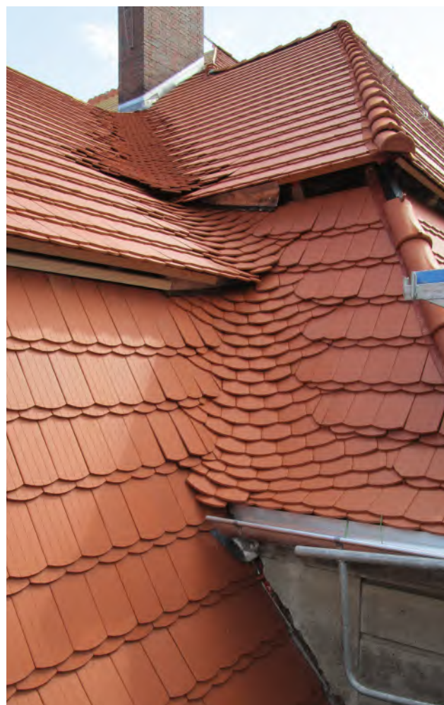
Abb. 2 Auch die Kehlen wurden gemäß historischem Bestand neu eingedeckt – HL/Abt. Denkmalpflege/Köhn.
