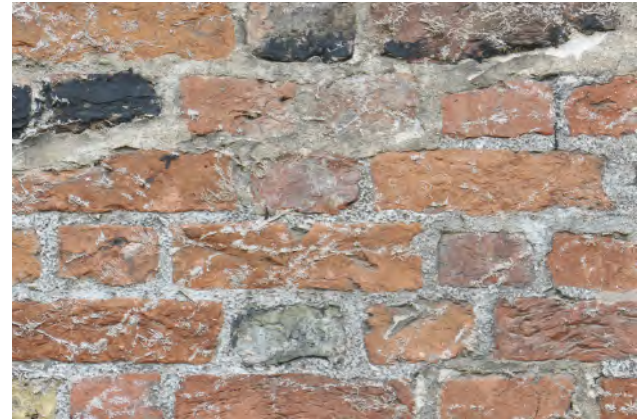
Abb. 4 Die Reste des entfernten Bewuchses wurden auf dem Mauerwerk belassen, um die Steinoberflächen nicht durch Strahl- oder Scheuerarbeiten zu beschädigen – HL/Abt. Denkmalpflege/Knipscheer.
