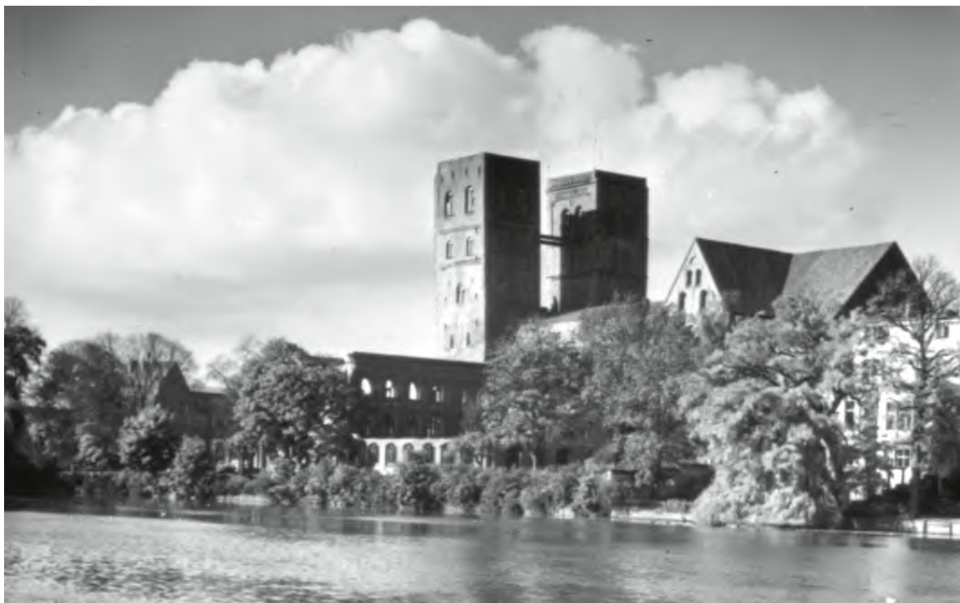
Abb 2 Hansestadt Lübeck, Dom, Zustand während der Instandsetzung der Turmschäfte nach der Kriegszerstörung Palmarum 1942, Ansicht vom Mühlenteich aus, 1957 – HL/Abt. Denkmalpflege/Wilde.
