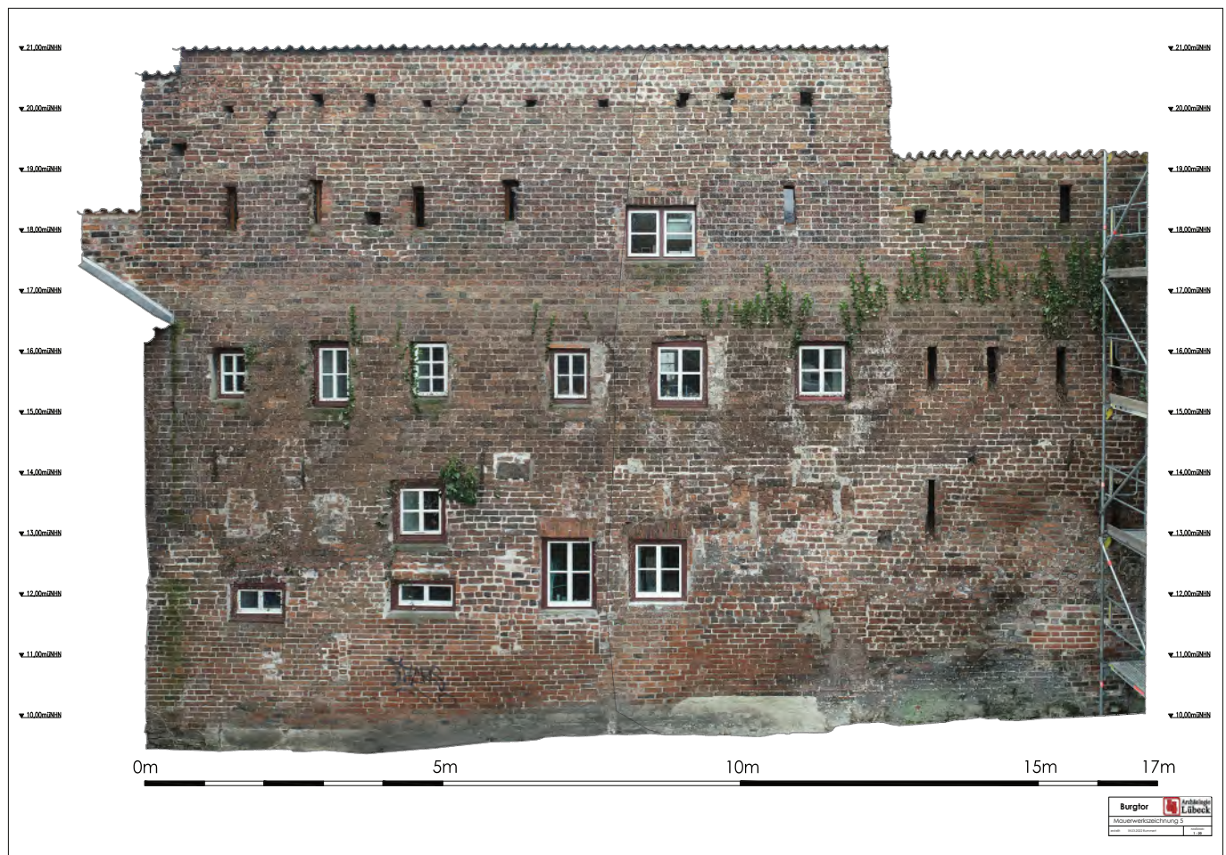
Abb. 5 Fotogrammetrisch erzeugte Ansicht der Wandfläche zwischen Kaiserturm und Zöllnerturm. Die Einzelaufnahmen werden bei diesem Verfahren entzerrt und mit entsprechender Software zusammengefügt. Das Ergebnis ist maßstabsgetreu und ermöglicht exakte Messungen im Foto – HL/Abt. Archäologie/Rummert.
